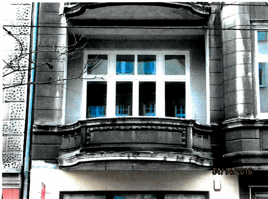
Rys. 19 Balkon na 1 piętrze z widocznymi sztukateriami na betonowej balustradzie, szczegół – pozycja nr 11, źródło własne
