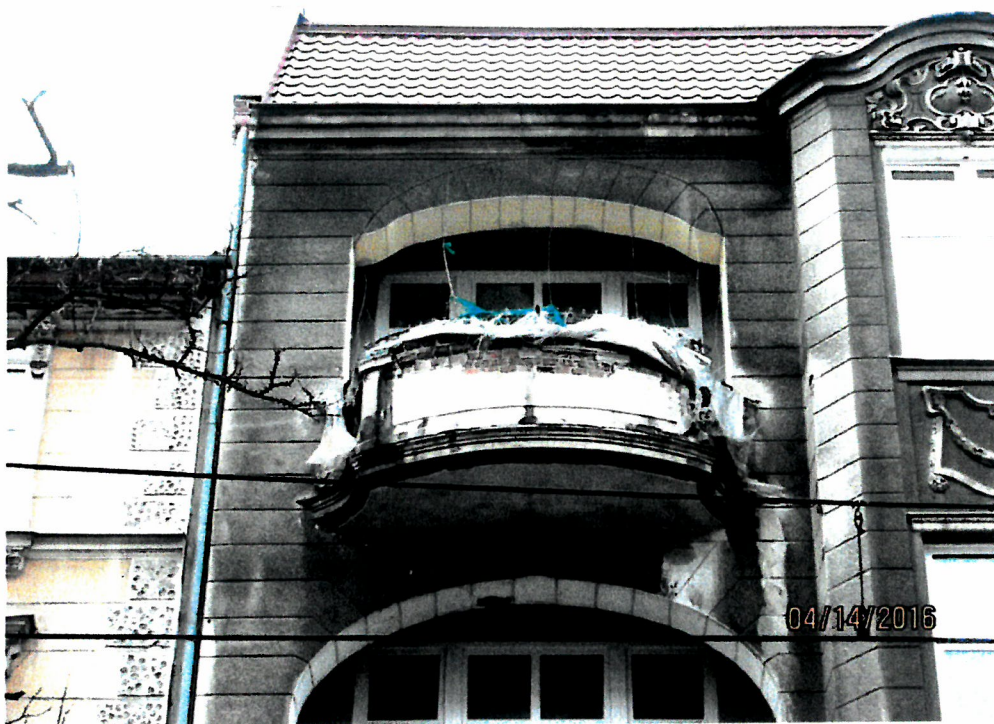
Rys. 21 Balkon na 3 piętrze z widocznymi sztukateriami na betonowej balustradzie, szczegół – pozycja nr 13, źródło własne
