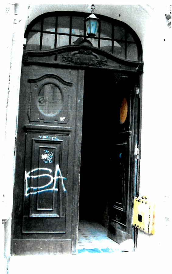
Fot. 13 Drzwi wejściowe – pierwotna stolarka
