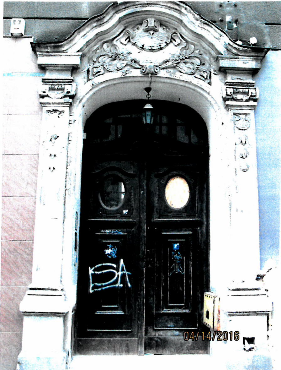
Rys. 13 Drzwi wejściowe na fasadzie kamienicy wraz ze sztukaterią na opasce drzwiowej oraz naczółek nad drzwiami, szczegół - pozycja nr 1, źródło własne
