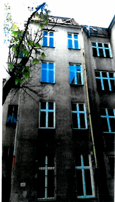
Rys. 12 Fragment elewacji północnej (wewnętrznej) z wymienionymi oknami PVC przed wykonaniem remontu elewacji kamienicy, źródło własne
