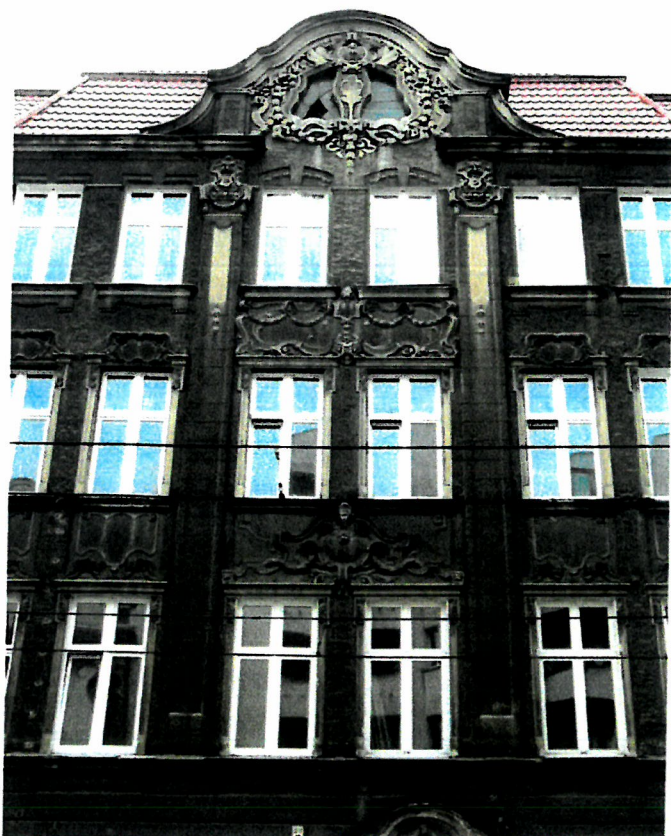
Fot. 1 Elewacja frontowa kamienicy ul. Kraszewskiego 11 (fragment centralny)
