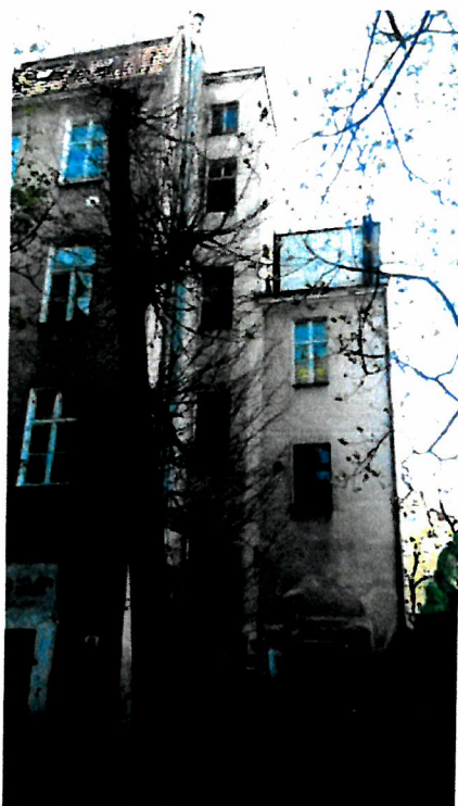
Rys. 9 Fragment elewacji południowej (wewnętrznej) oraz miejsce składowania odpadów komunalnych, źródło własne
