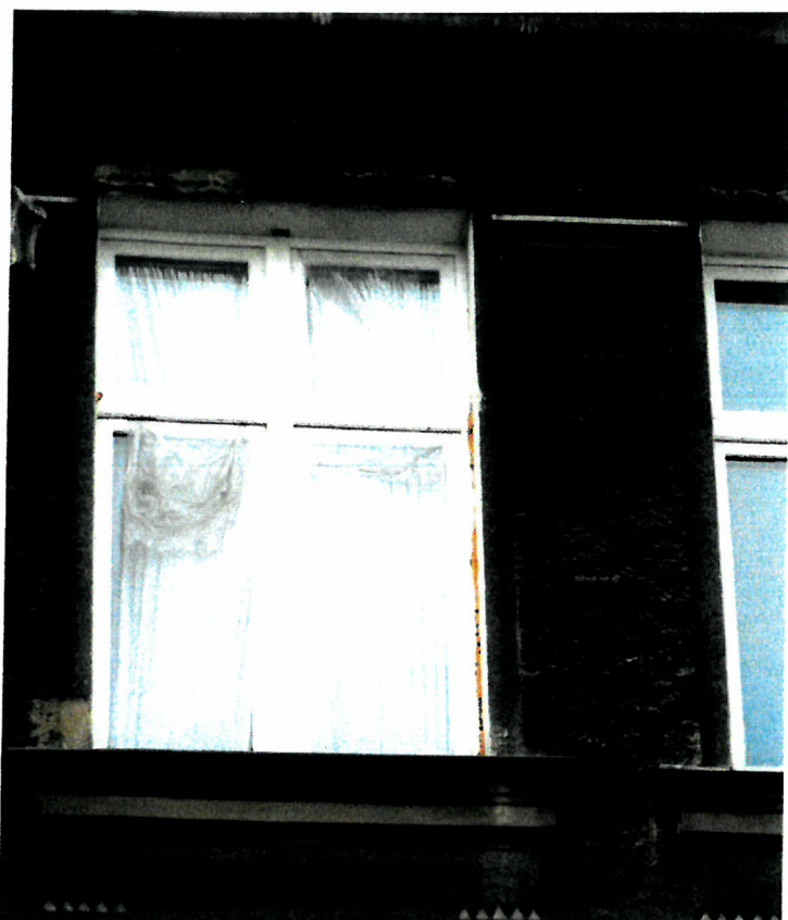
Fot.9 Fragment elewacji – brak elementu sztukatorskiego nad oknem, pierwotne tynki cyklinowane pokryte wtórnie tynkiem nakrapianym, tynkiem nakrapianym pokryto również elementy pierwotnie gładkie
