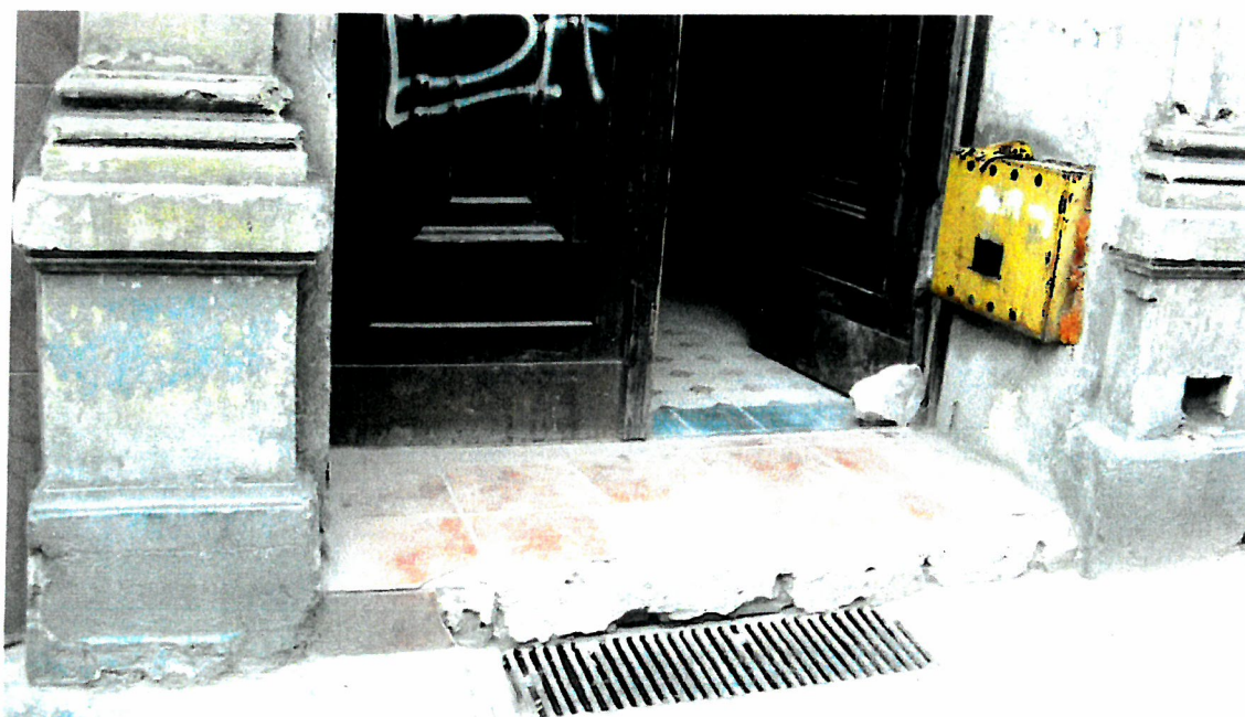
Fot. 14 Próg – wtórne obłożenie płytkami
