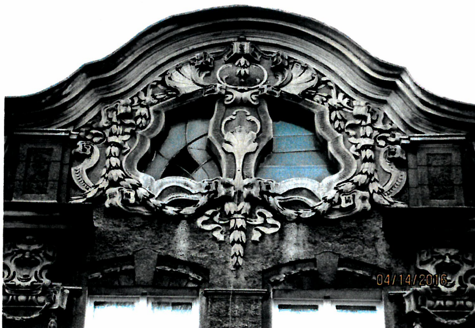
Rys. Okno na poddaszu wraz ze zdobieniami sztukatorskimi, należy usunąć wtórny tynk nakrapiany, szczegół – pozycja nr 4, źródło własne
