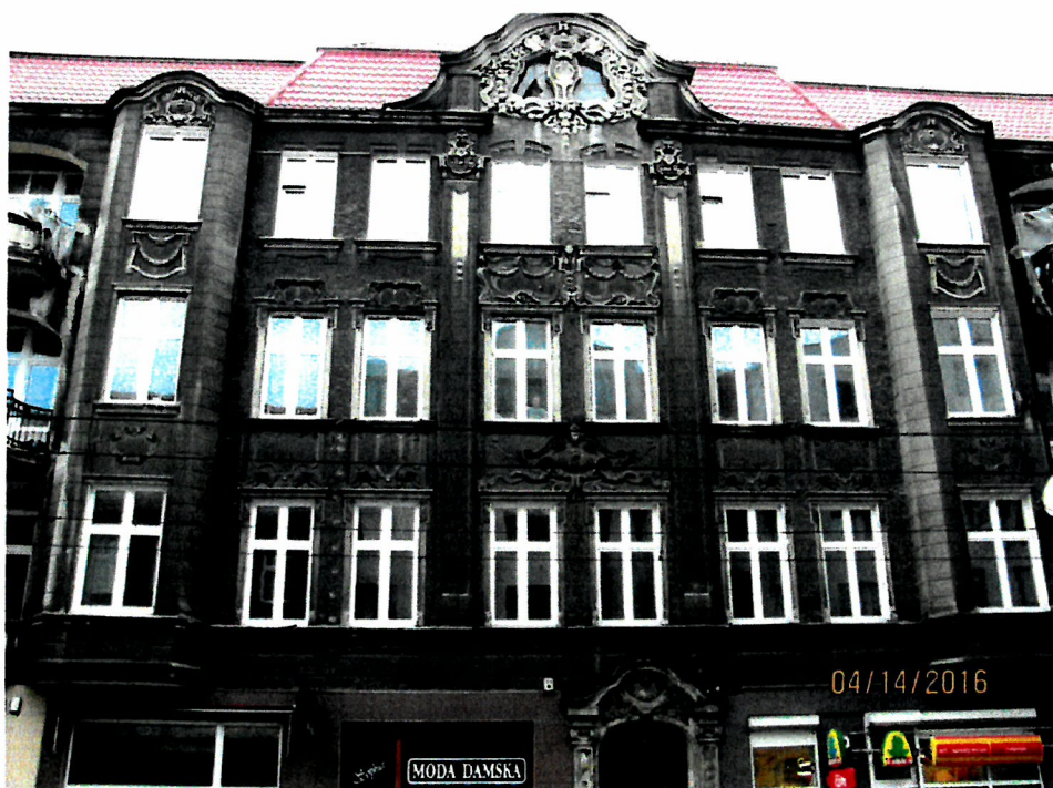
Rys. 3 Elewacja frontowa kamienicy, źródło własne
