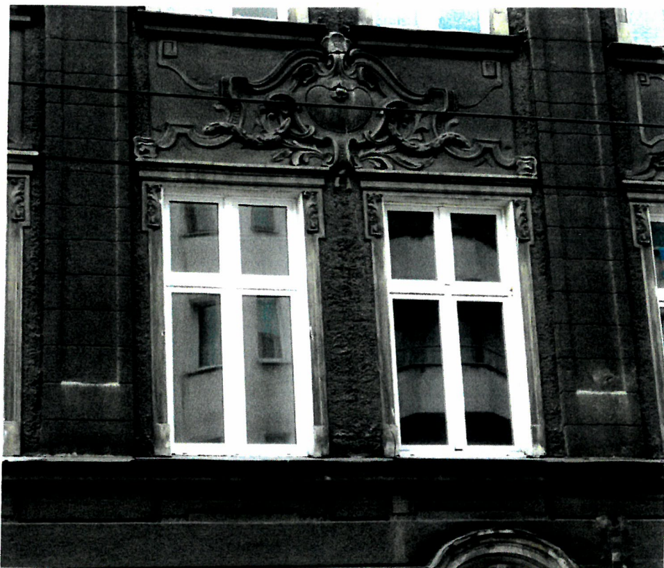
Fot. 5 Fragment elewacji – na boniach wtórny tynk nakrapiany
